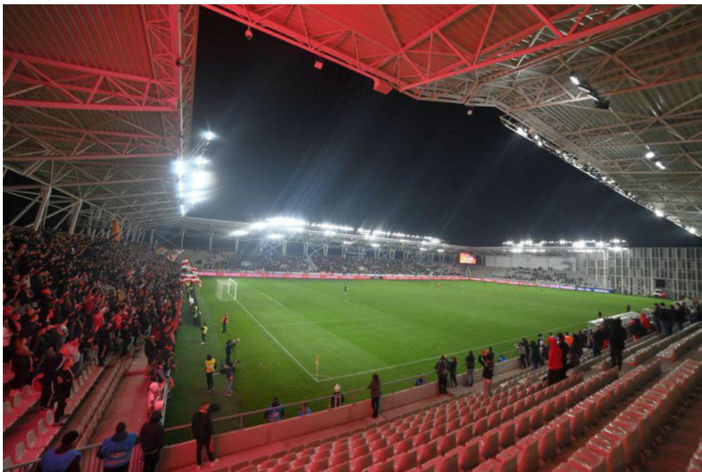
Figura 137 Stadionul "Arcul de Triumf", Sursa www.gsp.ro
